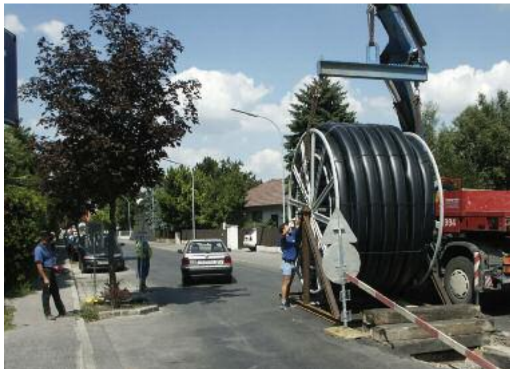
■ Mittels Inliningverfahren wird das Leitungsnetz des WLV saniert
