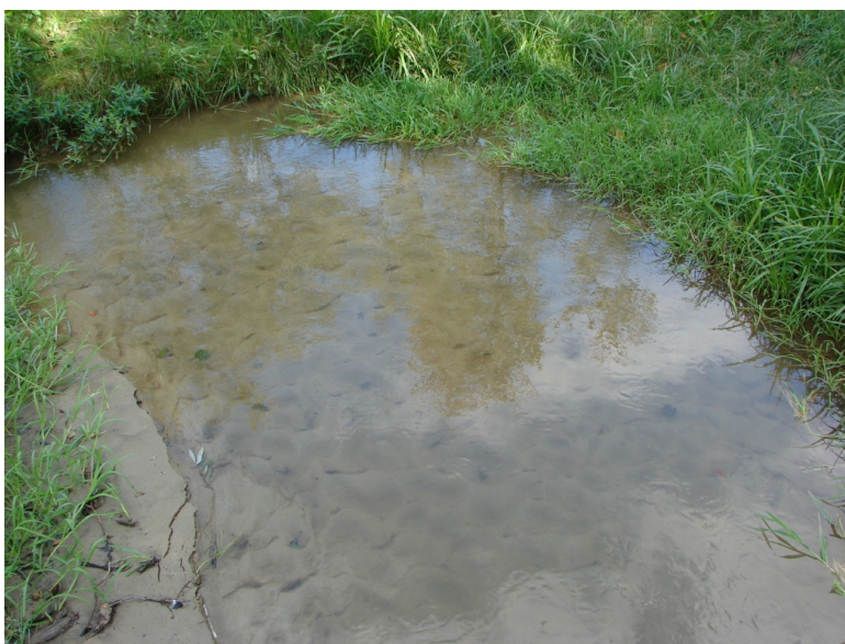
Abb. 33. Oberstes „Becken“ im Fischaufstieg bei der Großsiedlmühle. Aufgrund der starken Verlandung ist die Dotation von ursprünglich 100 \text{ L s}^{-1} stark reduziert, die einzelnen Becken sind massiv verschlammmt.
