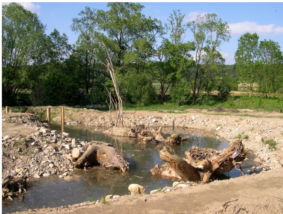
Abb. 26. Unterster Abschnitt der Teichanlage – Stand Mai 2011.
