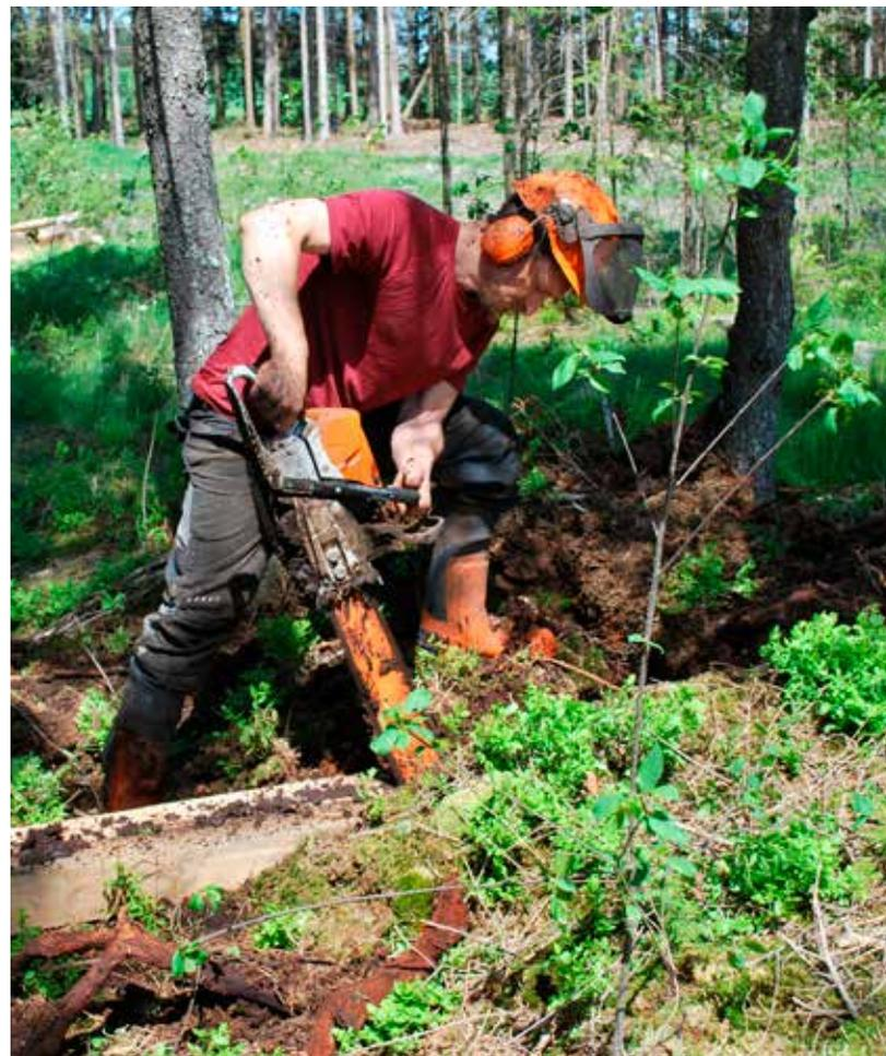
Beim Moorsanierungsprojekt Bruckangerlau durchschneidet Gernot Mühlberger den Torfkörper, um das Einschlagen der Grabensperren zu erleichtern.
