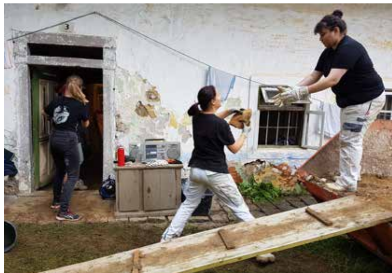
Frauen am Werk beim Sanieren der Schörgendorfer Mühle.
