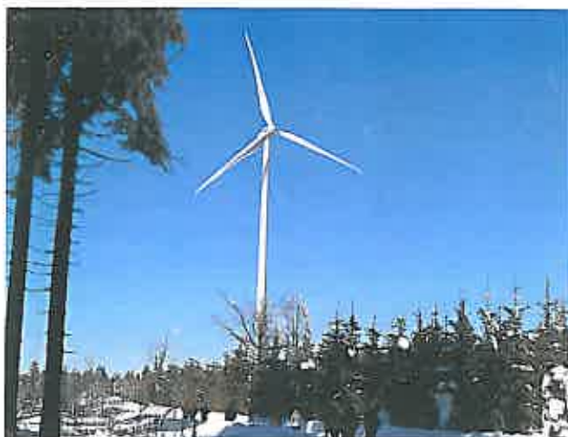
Im Windpark Sternwind sind sieben Windräder in Betrieb.
