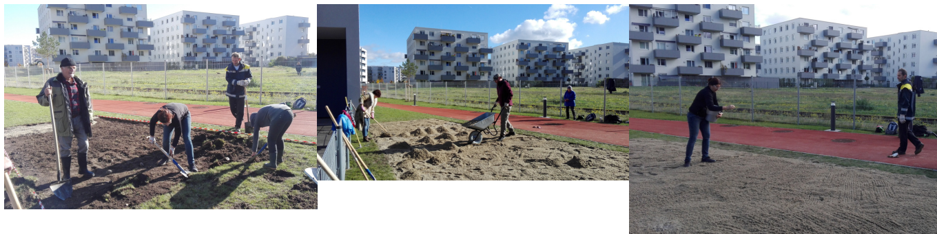
Abheben der Rasensoden. Aufbringen des nährstoffarmen Sandes. Aussaat des Wiesen-Saatguts.
